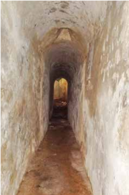
Galería de comunicación del abrigo (D) con el puesto de observación oriental (B). En la bóveda se aprecia un orificio de ventilación.
