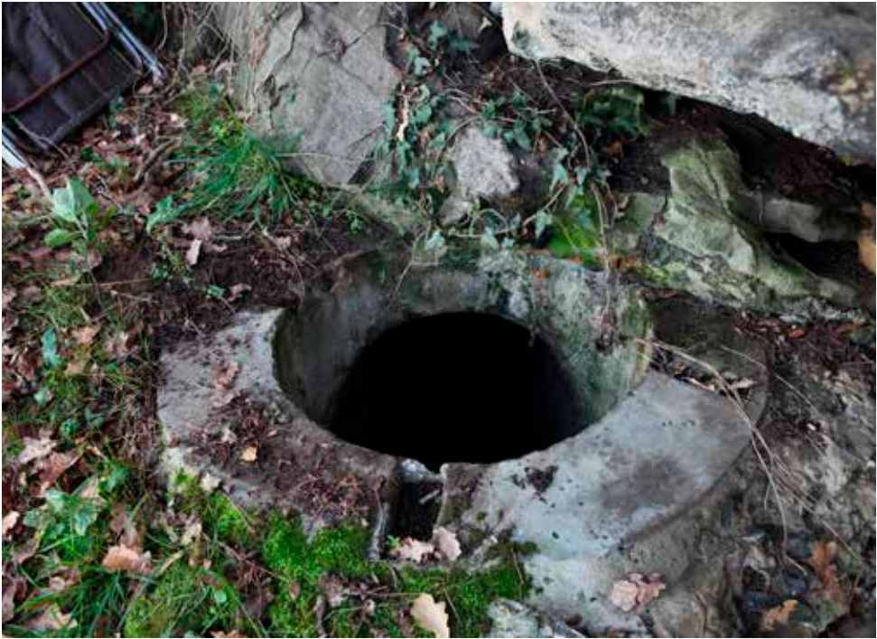
Puesto de observación oriental (B), boca con sus tres hendiduras para ajustar un cierre.
