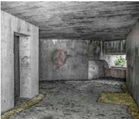
ODP en Aragón. Bunker para un cañón contracarro en el "Paseo de los Melancólicos" de la localidad de Canfranc. A la izquierda se aprecia el repuesto de munición y a la derecha, la cañonera, con el espacio para la colocación de las ruedas de la pieza de artillería. También se aprecia en el suelo la hendidura con tierra destinado a acoger el extremo de los mástiles. Son búnkeres notablemente más grandes que los destinados a albergar. ametralladoras y fusiles ametralladores.
