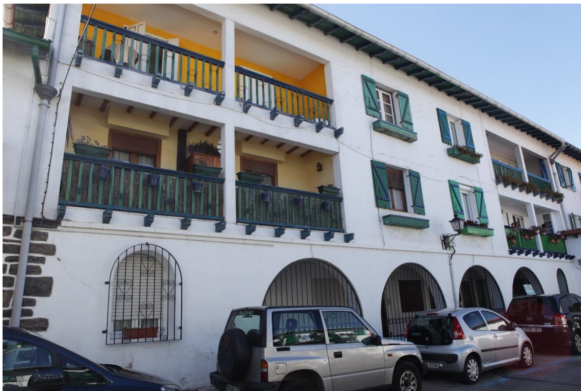
8/ Edificio 1 (tipo G). Se observan en los extremos de la planta baja dos vanos y, entre ellos, cuatro arcos, así como los balcones retranqueados de la primera y segunda plantas.
