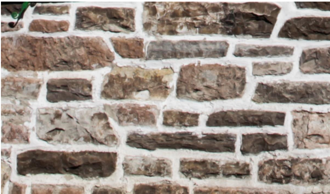
15/ La mampostería, principalmente en las primeras plantas parece resaltar decorativamente el carácter rural o pesquero de la construcción.
