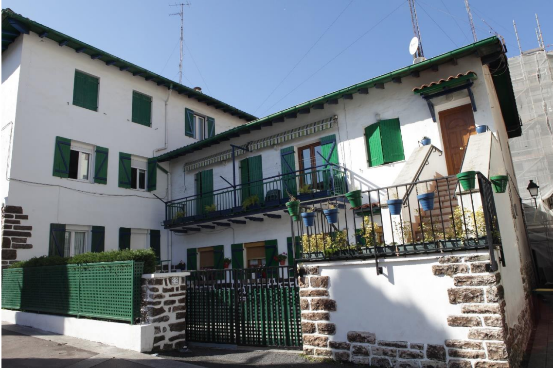
17 Edificio n. 7 del plano (Arrantzale auzoa 22) conserva sus elementos originales.
