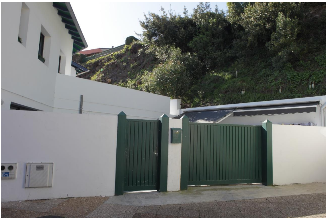
27/ Fachada trasera del edificio 15 del plano (17 de Arrantzale auzoa) (remodelada en 2016) con el cierre del terreno que le corresponde.
