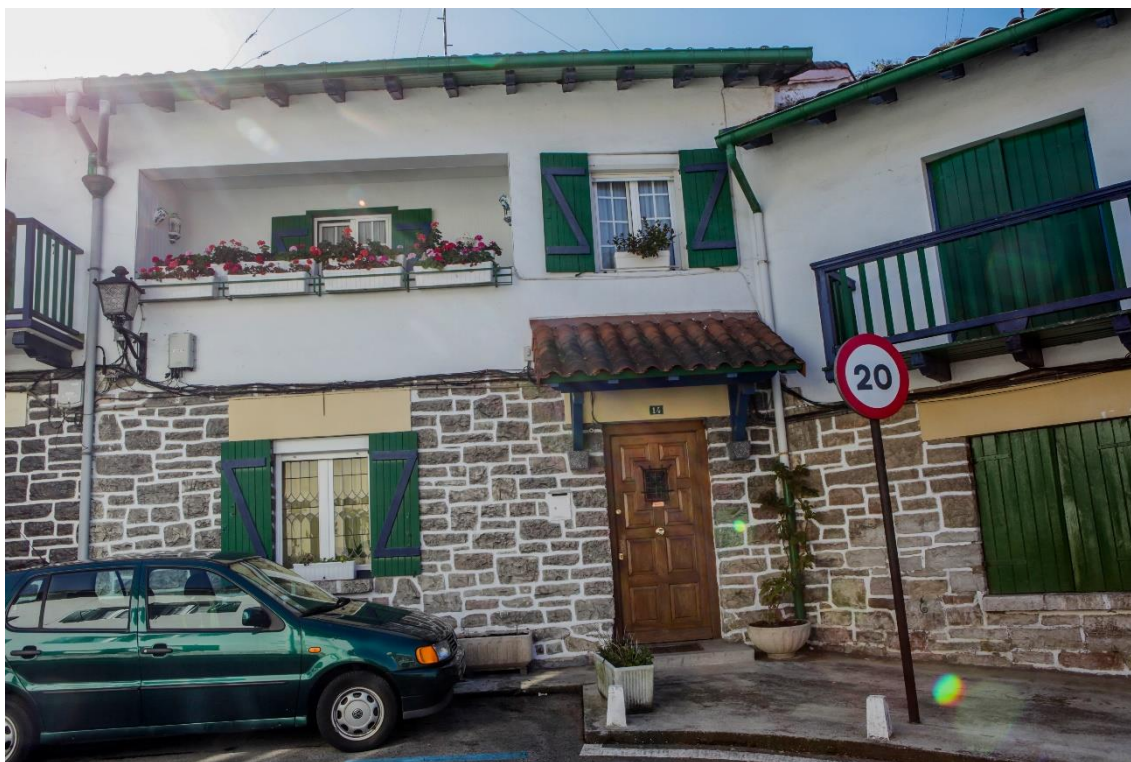
25 Edificio n. 14 (del plano) (portal también 14)
