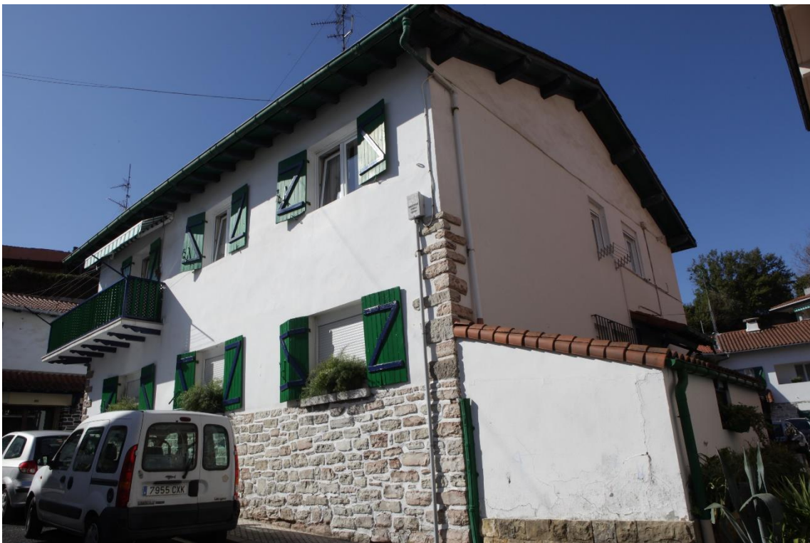
28 Edificio n. 16 del plano. Se observa el balcón en esquina y el anexo que se apoya en la otra fachada.
