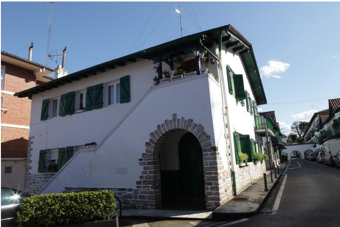
30 Acceso a planta baja retranquedo formando un pequeño atrio bajo arco de medio punto. Se observa también el patín que da acceso a la planta superior.
