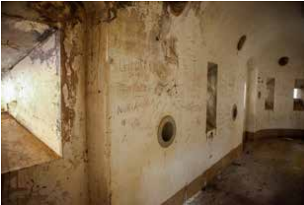
Uno de los dos sectores de galería de escarpa que defienden el fosete y el foso en torno a la caponera de gola.
