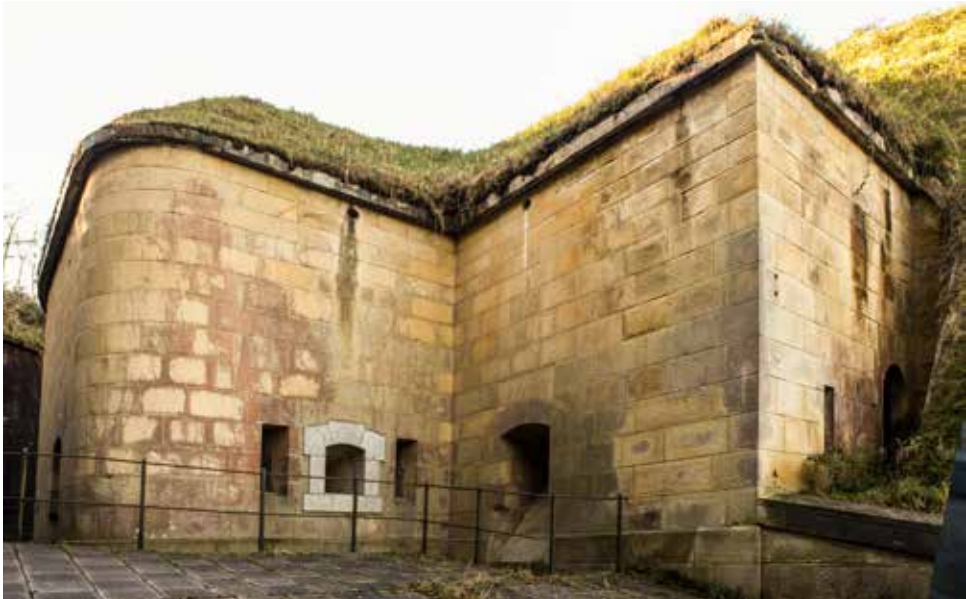
Frente oriental de la caponera suroeste. Se observa la cañonera y las dos aspilleras del frente, así como un matacán para defensa del fosete. A la derecha, la puerta de acceso al camino de ronda de la escarpa.
