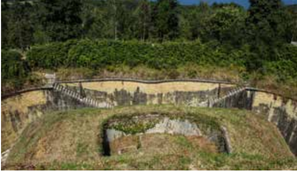
Parapeto de fusilería sobre la caponera de gola. Domina las escaleras de contraescarpa, camino cubierto y dos sectores del foso También tiene vistas sobre el mar.
