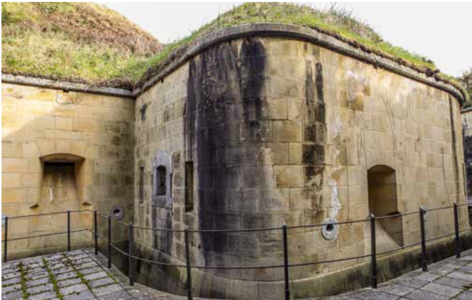
Caponera sureste Se aprecian varios matacanes, aspilleras, lanzagranadas y la cañonera para flanqueo del foso.
