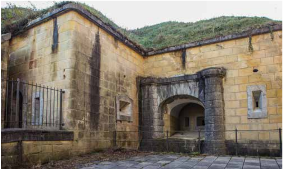
Frente NE de la caponera de gola (3). A la izquierda se observa la puerta de salida al camino de ronda y en el centro la cañonera principal y dos aspilleras protegidas por una cañonera-túnel o visera. Se observan igualmente dos aspilleras que baten también el foso: a la izquierda horizontal y a la derecha vertical.
