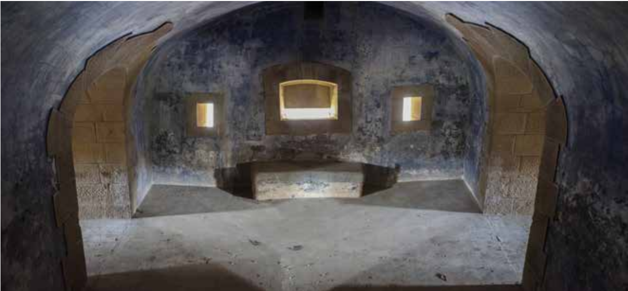
Caponera sureste. Espacio interior donde finaliza la poterna (5) que da acceso a las dos casamatas (1). Se aprecia un matacán con su banqueta y dos aspilleras que corresponden a las que se aprecian en la fotografía superior izquierda.
