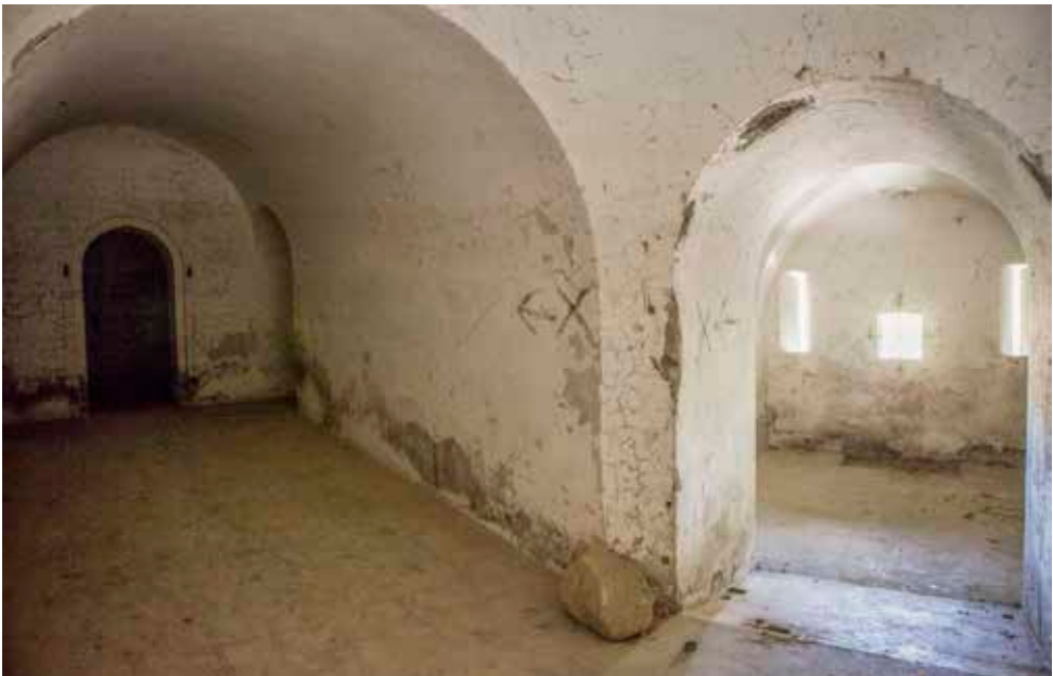
Caponera suroeste. A la izquierda bóveda de acceso (9) a las casamatas con el repuesto de munición (2) al fondo. A la derecha, la casamata oriental (1a), con su cañonera y dos aspilleras.
