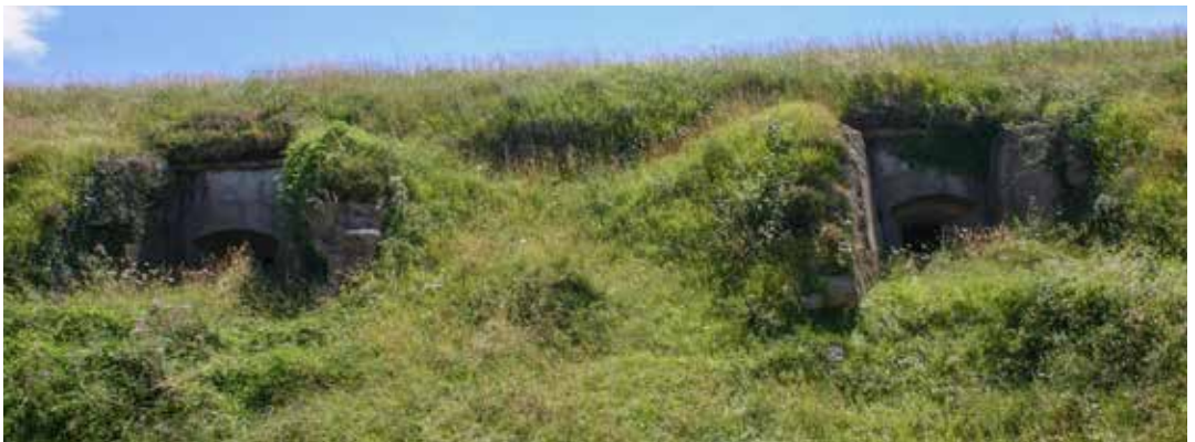
Exterior del frente norte de la batería acasamatada, en la que se aprecian dos cañoneras con sus muros de ala y el desprendimiento de tierras entre ellos.
