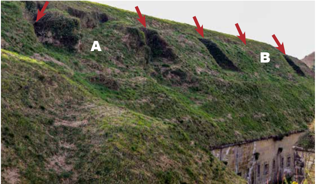
Exterior del frente norte de la batería acasamatada. Se observan las aberturas de las cañoneras (flechas) en el blindaje de tierra, desprendido (A y B) en dos sectores.
