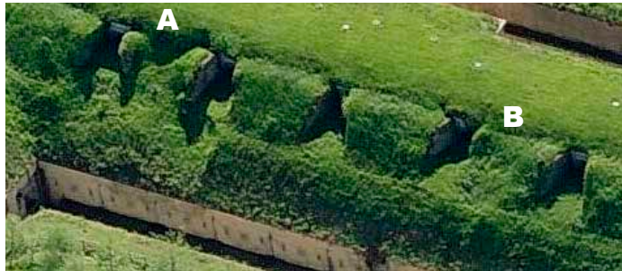
Exterior del frente norte de la batería acasamatada. Se observan las aberturas de las cañoneras (flechas) en el blindaje de tierra, desprendido (A y B) en dos sectores.
