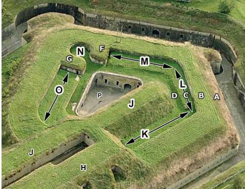
A: Talud de escarpa. B: Parapeto. C: Adarve de combate. D: Adarve de servicio. F y G Traveses. H: Cuartel y batería acasamatada. J: Máscara de protección. Frentes: K: Norte. L: Noroeste. M: Suroeste. N: Asentamiento circular. O: Sureste. P patio principal.
