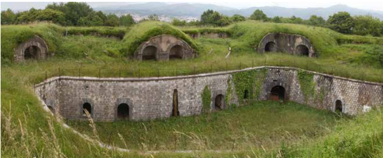
Fot. inferior: vista del patio desde la cubierta del cuartel de artillería. Se aprecian también los terraplenes de servicio y combate, así como los traveses del frente oriental.
