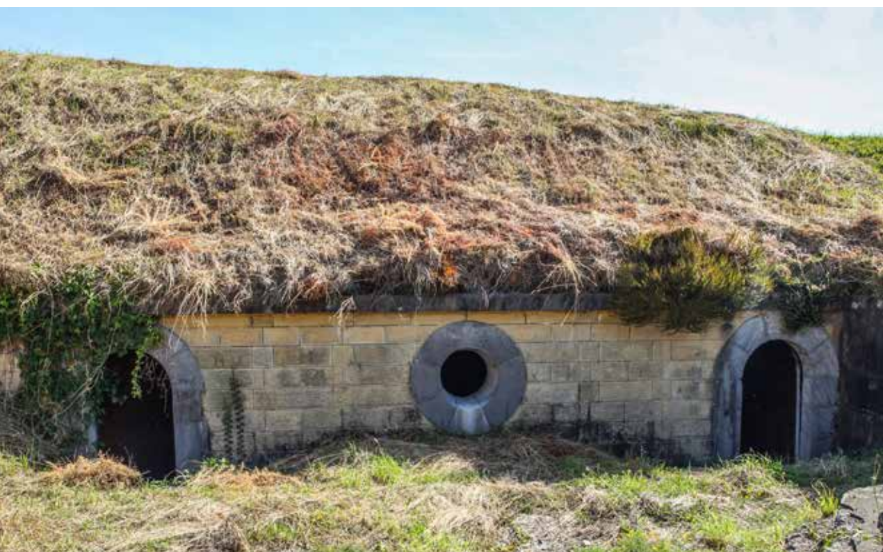
Almacén de efectos de artillería de la Obra del Centro
