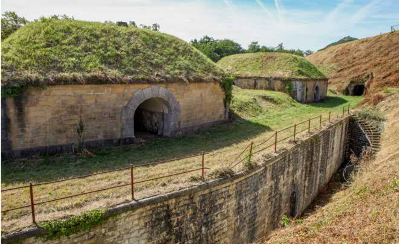
Obra del centro: patio de la obra, terraplén de servicio y traveses.
