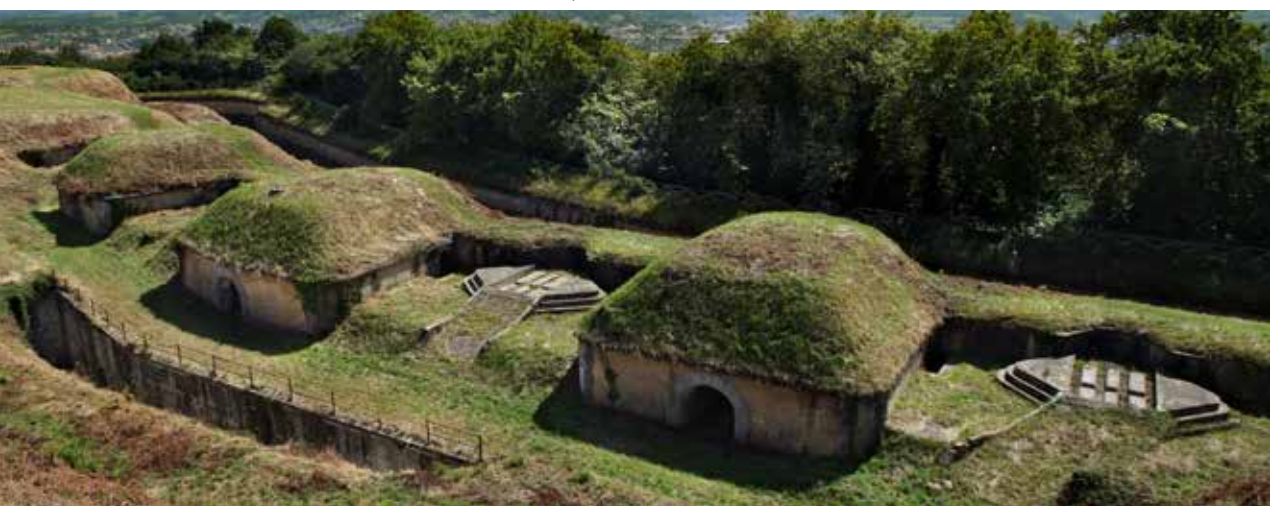
Vista general de la Obra, con sus tres traveses y las explanadas con sus rampas.
